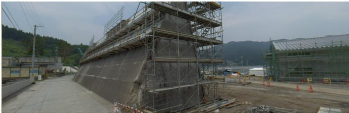
Fig. 3: 大船渡市越喜来地区における二線堤の建設 (2016年6月). 右後方が海側で、同時に進行している外堤防の建設が望める
